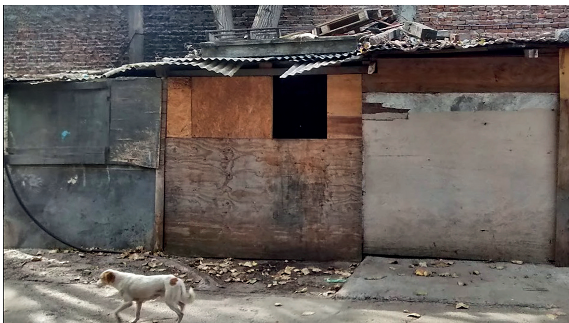
Figura 1. Exterior de la casa de Carlina.
