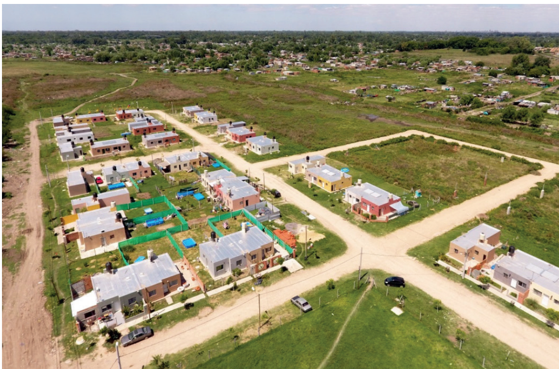
Figura 3. Barrio Suelo Firme.
