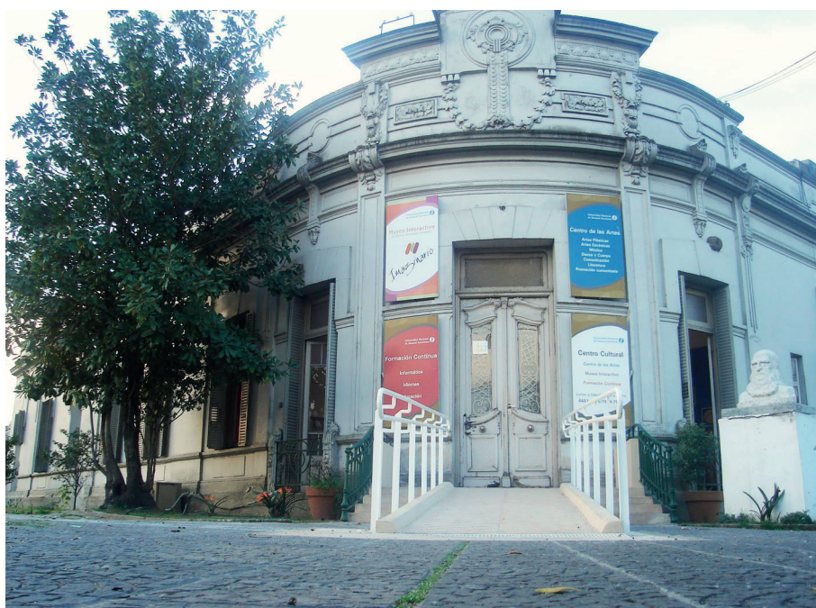
Fachada del Centro Cultural de la UNGS.
