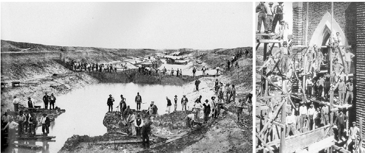
Figura 1. Obreros trabajando. a. puerto b. catedral.
