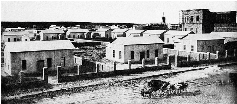
Figura 2. Viviendas importadas. Calle 7 entre 45 y 46.
